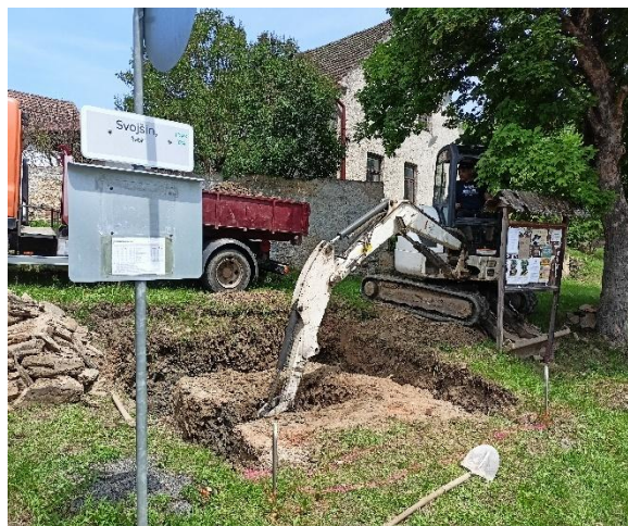
Zahájení výstavby kaple Panny Marie v Řebří, v místě, kde kaple stávala.
