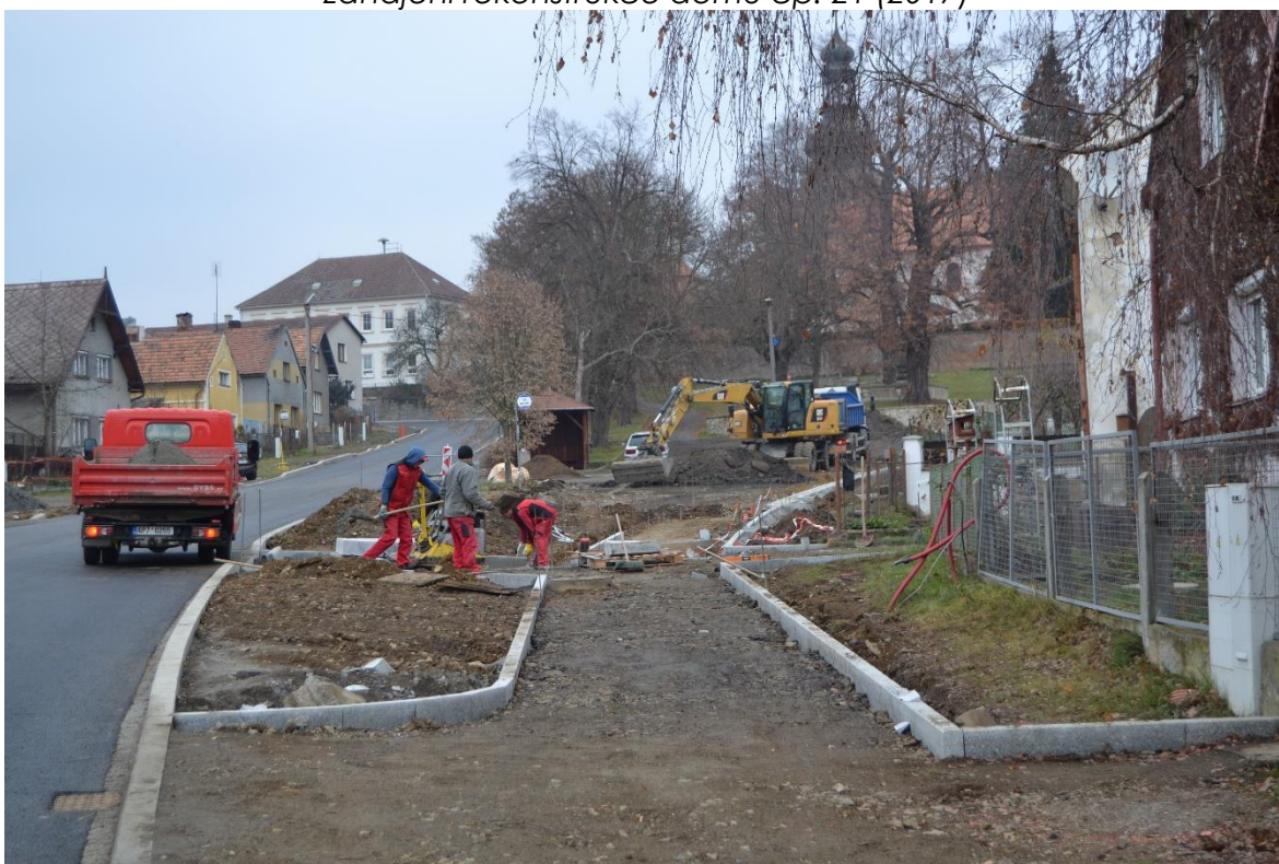
Zahájení rekonstrukce návsi (2018)
