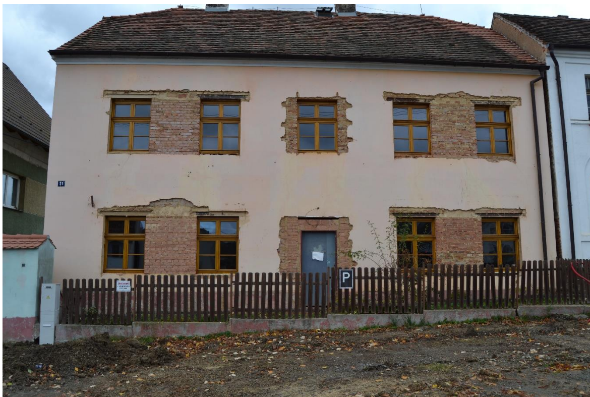
Zahájení rekonstrukce domu čp. 21 (2017)
