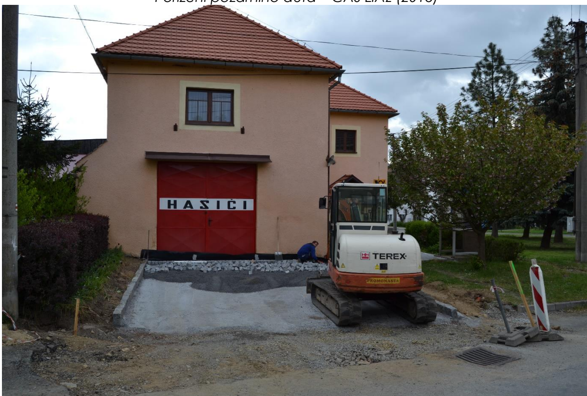
Zpevnění povrchu před hasičskou zbrojnicí a obecním úřadem (2016)
