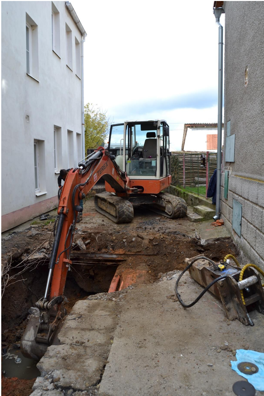
Odkanalizování budovy ZŠ a dalších objektů (2016)
