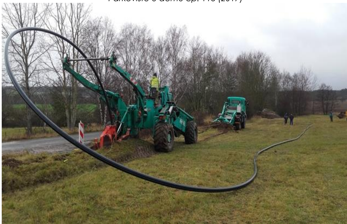
Výstavba vodovodního přivaděče z Pražky (2017)
