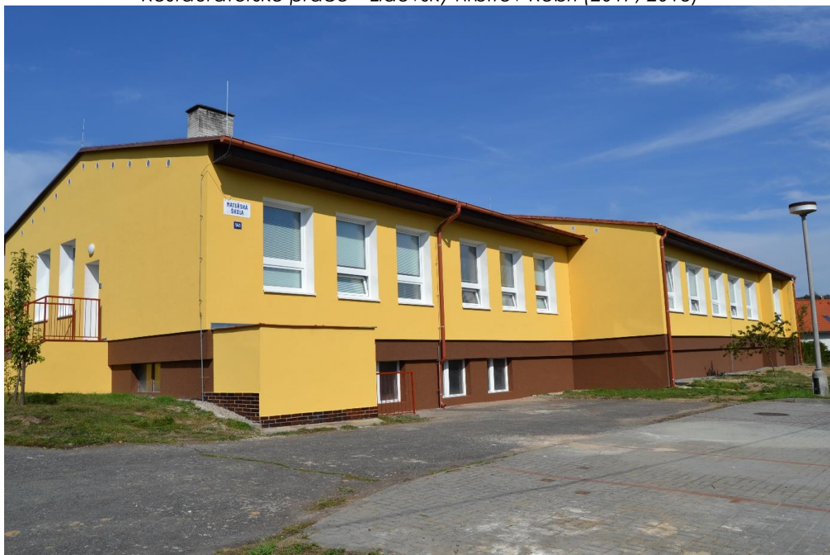
Rekonstrukce budovy MŠ (2018)
