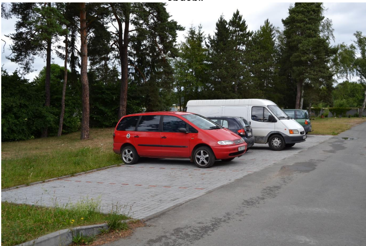
Výstavba parkoviště na Komíně (2015)
