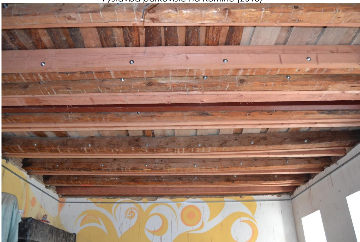
Oprava stropů ZŠ (2015)
