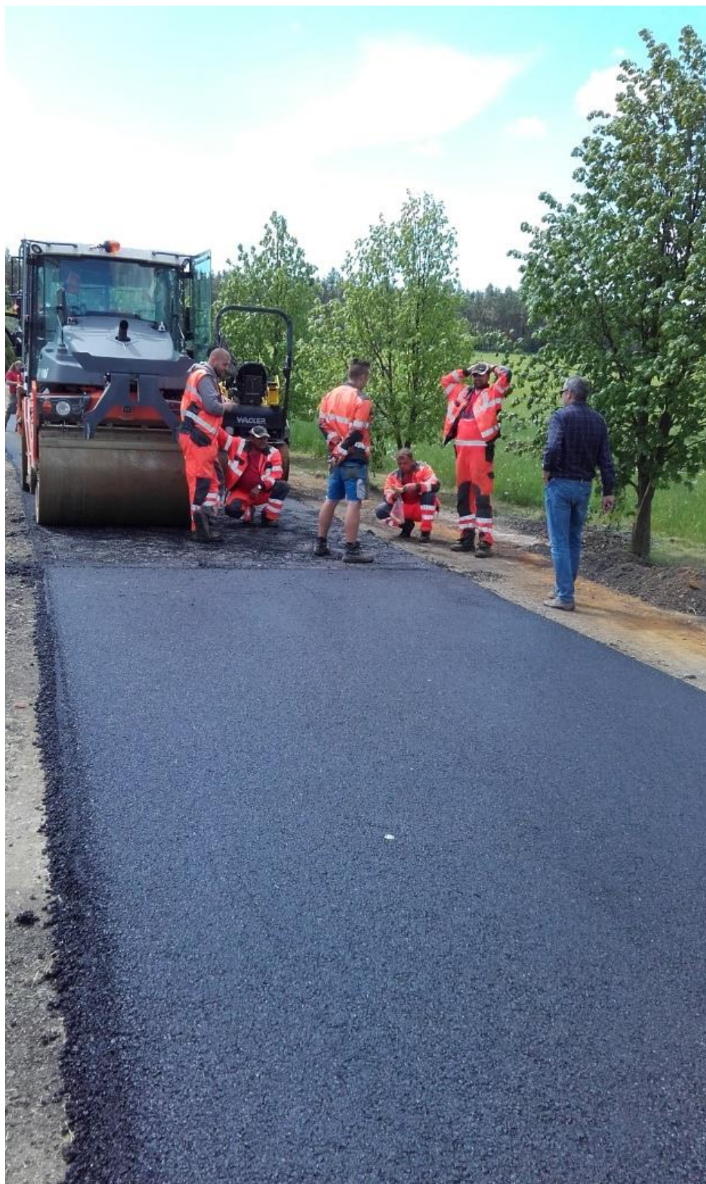
Oprava cesty na Nynkově (2016)
