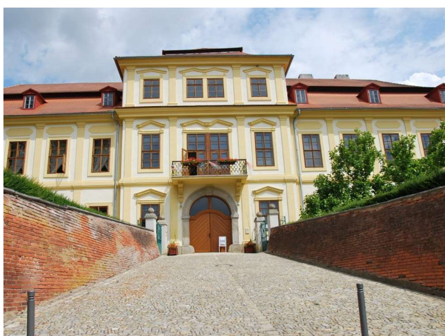
Obnova dlažby před zámkem
