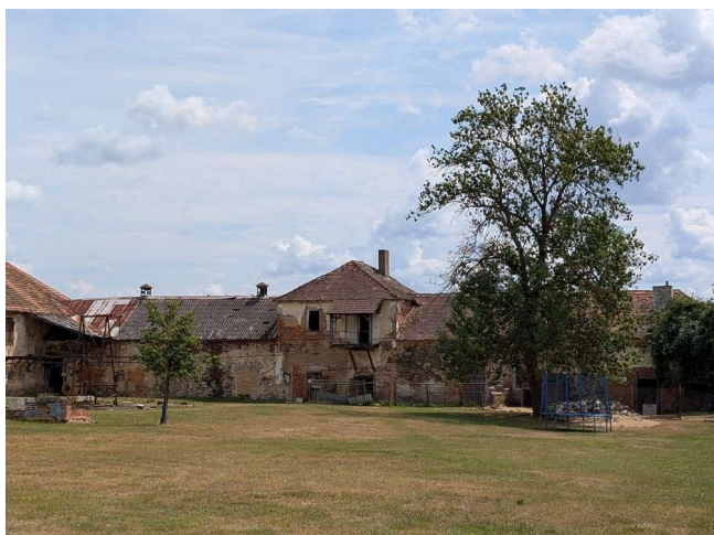
Rekonstrukce bývalé konírny
