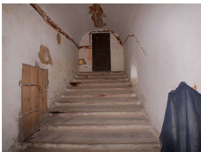
Torzo služebního schodiště 1.NP zámek
