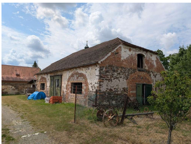
Rekonstrukce hospodářských budov
