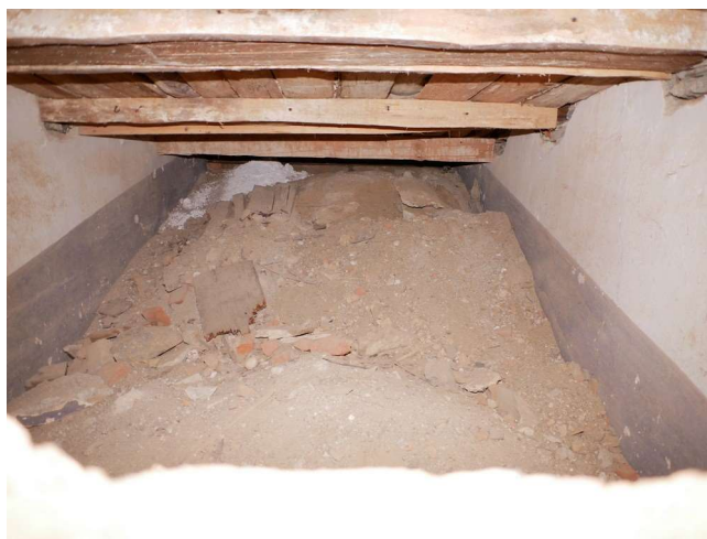
Služební schodiště zrušené rameno 2.NP
