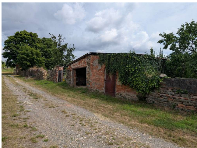
Rekonstrukce hospodářských budov
