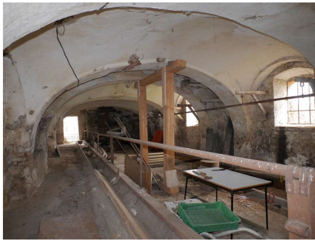
Rekonstrukce bývalé konírny
