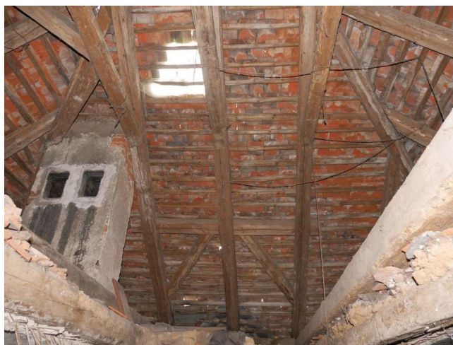
Konírna rekonstrukce krovu a střechy
