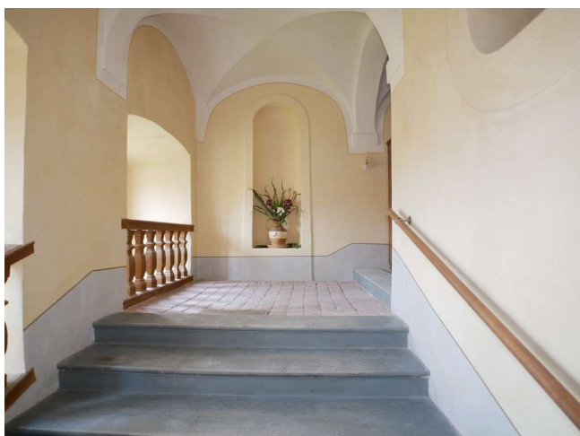
Hlavní schodiště do 3.NP restaur.
