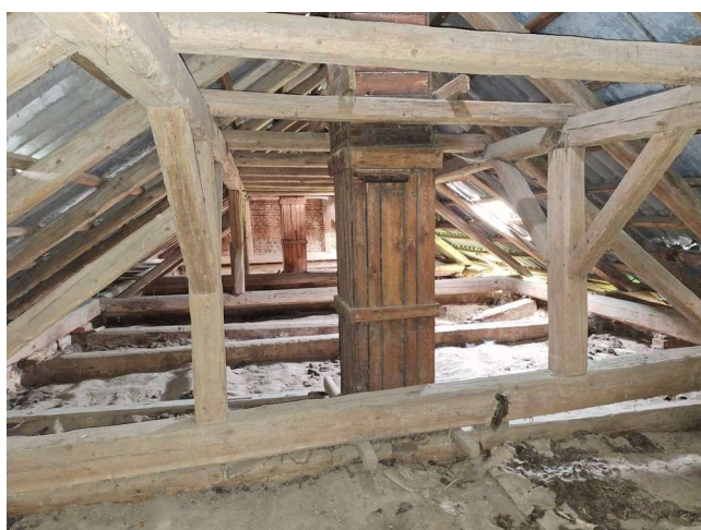
Konírna rekonstrukce krovu a střechy
