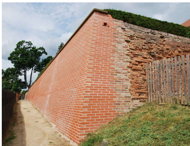
Rekonstrukce jižní zdi východní terasy
