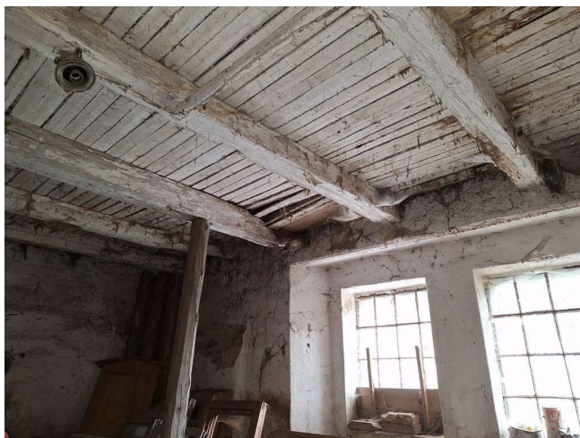
Rekonstrukce bývalé konírny
