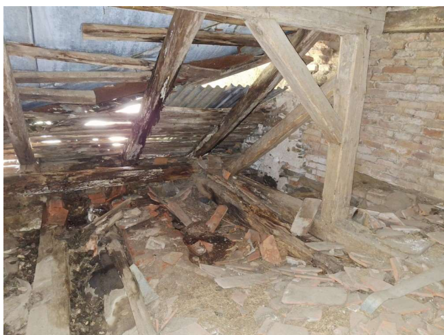
Konírna rekonstrukce krovu a střechy
