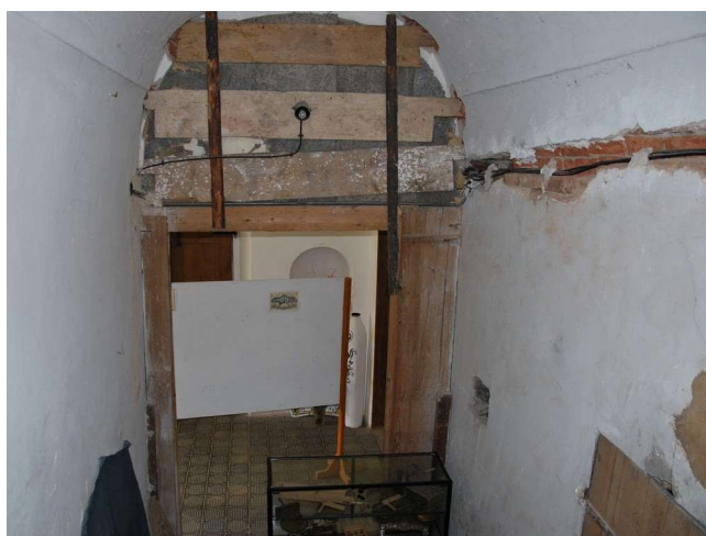
Služební schodiště příčka u vstupu
