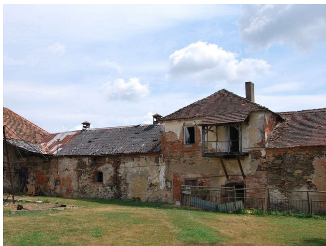
Bývalá konírna severní část
