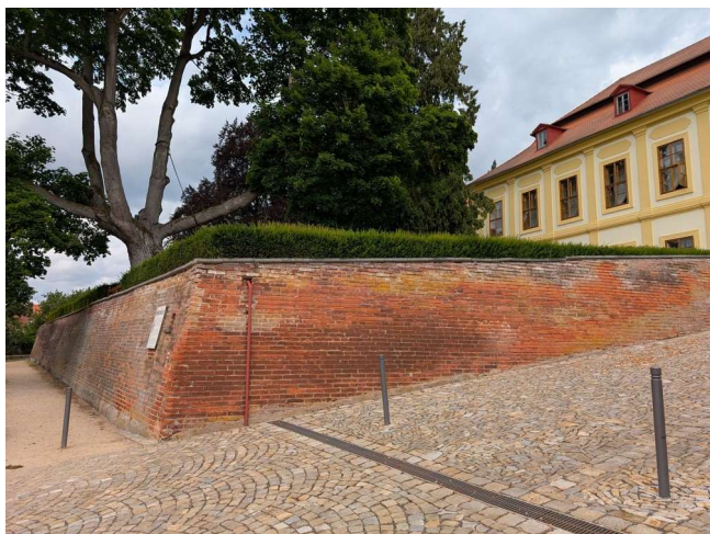
Pokrač. rekonstrukce terasních zdí
