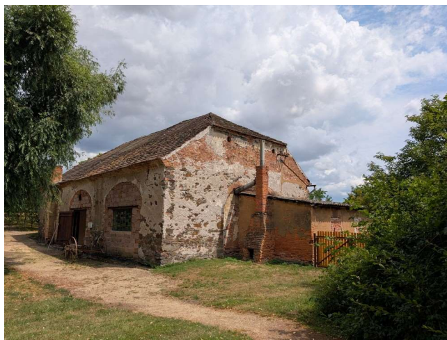
Rekonstrukce hospodářských budov
