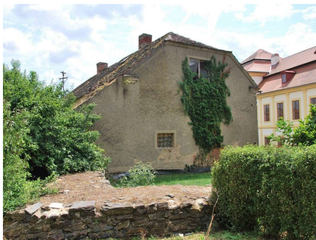
Rekonstrukce domu správce
