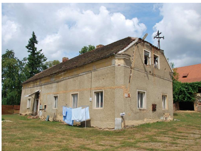
Rekonstrukce domu správce
