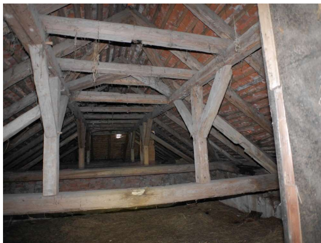
Konírna rekonstrukce krovu a střechy
