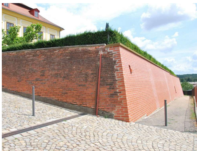
Rekonstrukce jižní zdi východní terasy
