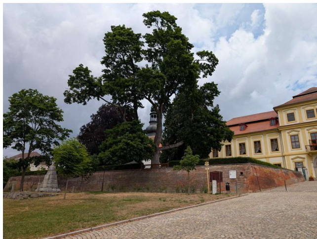
Pokrač. rekonstrukce terasních zdí
