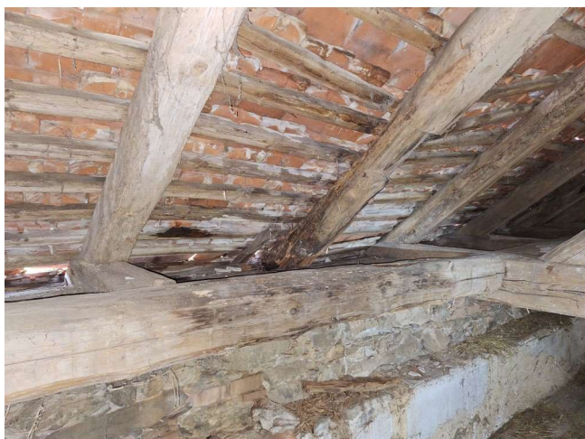
Konírna rekonstrukce krovu a střechy
