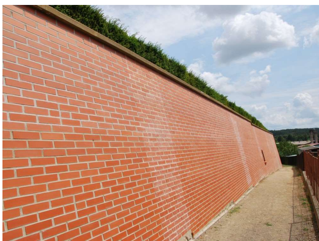
Rekonstrukce jižní zdi východní terasy
