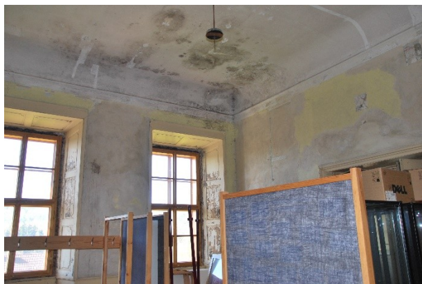
Restaurování interiéru vých. části 2.NP
