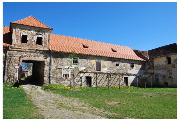
Rekonstrukce hospodářských budov
