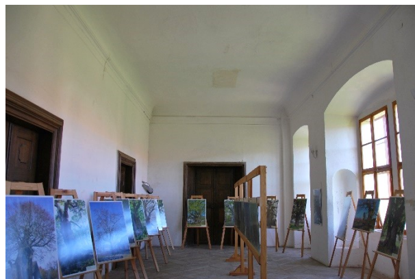
Restaurování interiéru vých. části 2.NP
