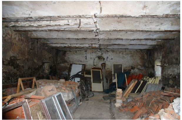
Rekonstrukce hospodářských budov
