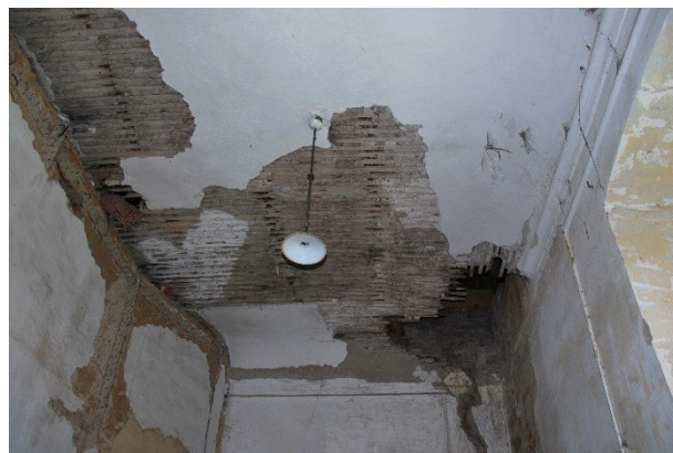
Restaurování interiéru vých. části 2.NP
