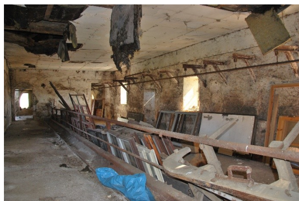
Rekonstrukce hospodářských budov
