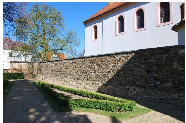
Oprava zdi pod kostelem
