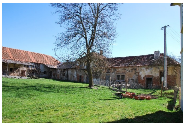
Rekonstrukce hospodářských budov
