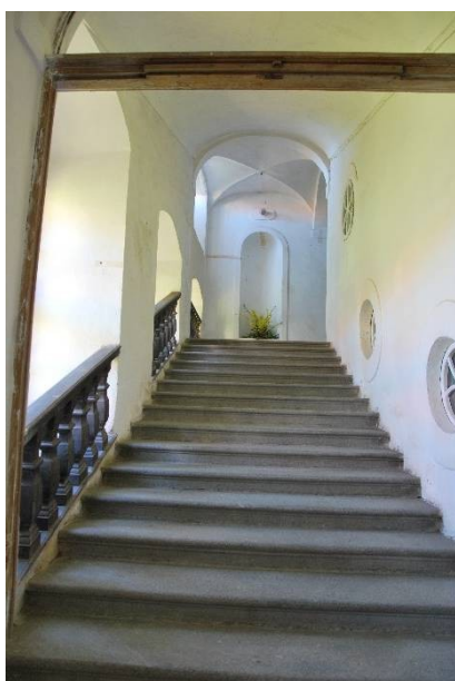
Restaurování interiéru vých. části 2.NP
