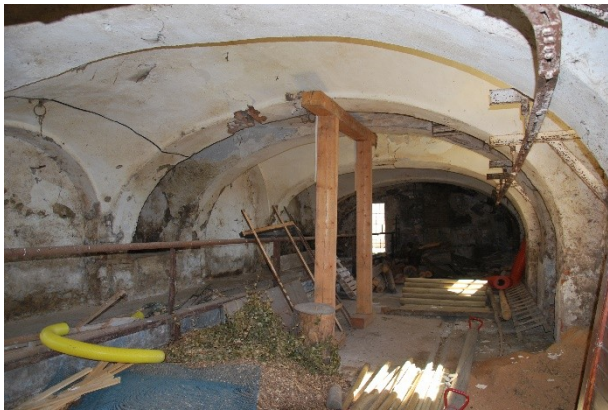
Rekonstrukce hospodářských budov
