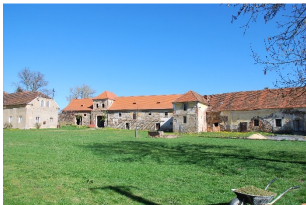
Rekonstrukce hospodářských budov
