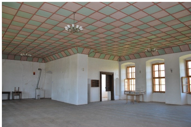
Obnova východní části sál 2.NP
