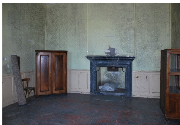
Restaurování interiéru vých. části 2.NP
