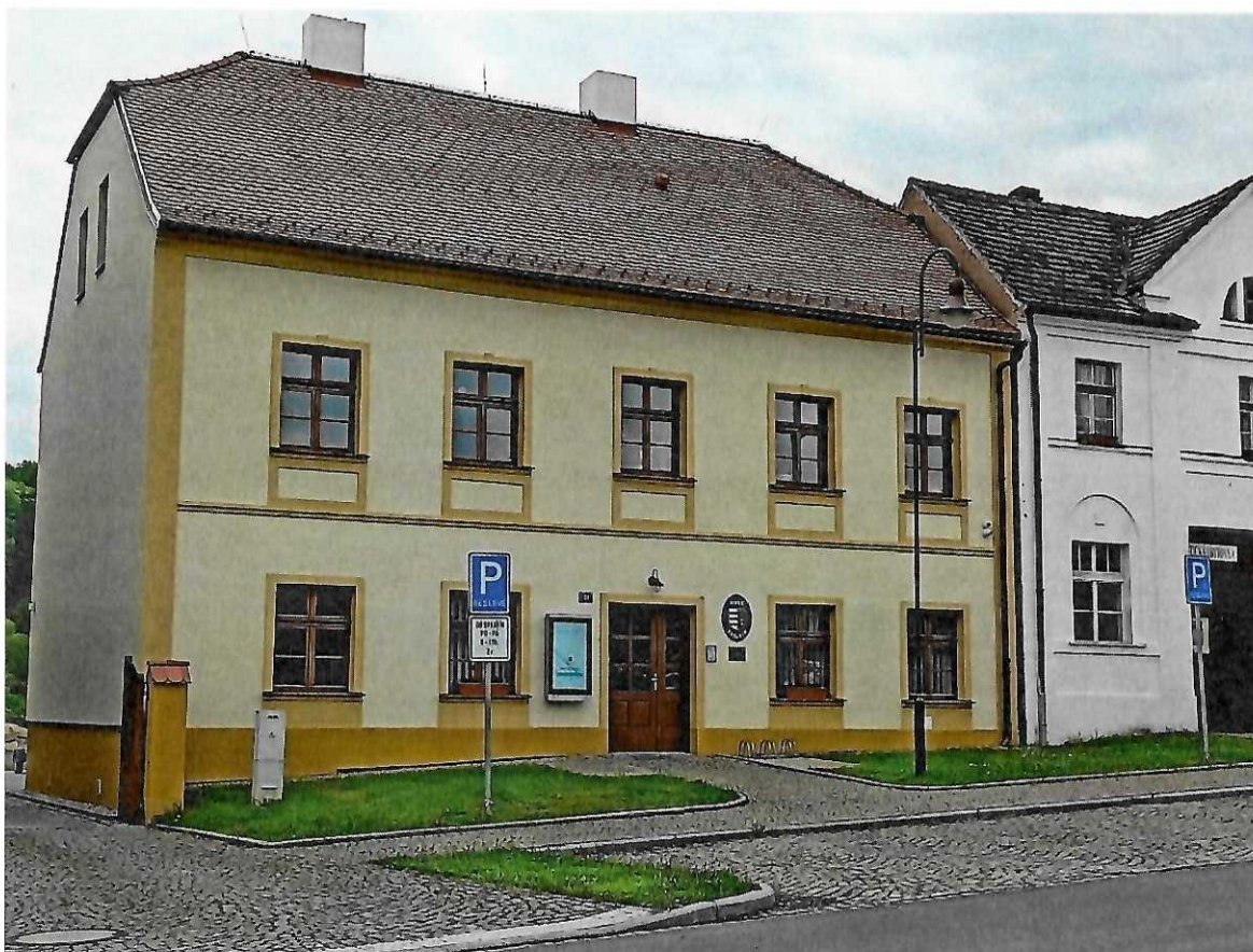
Obrázek 9: Rekonstruovaná budova obecního úřadu ve Svojšíně (Obec Svojšín, 2023)
